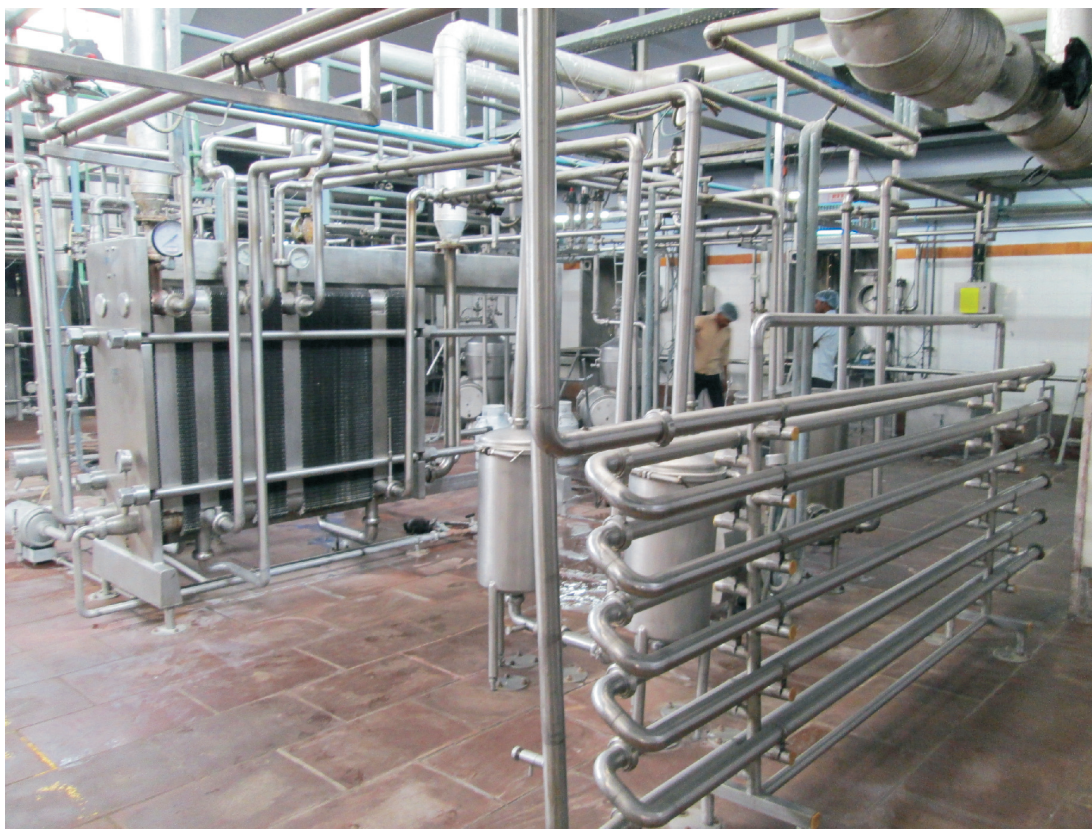
Fig.8.2. HTST Pasteurizer
